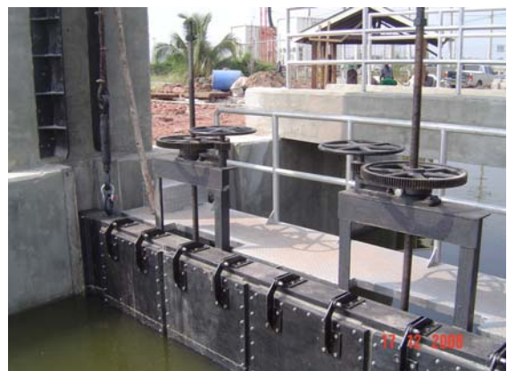
ประตูระบายน้ำรุ่นใหม่ แบบบานสวิง หรือ บานหับเผย หรือ แบบภูมิปัญญาชาวบ้าน ตำบลแพรกหนามแดง
