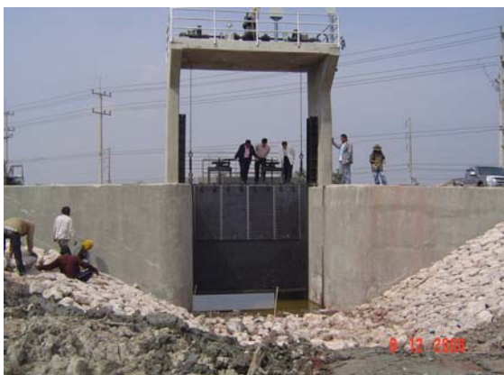
ประตูระบายน้ำรุ่นใหม่ แบบบานสวิง หรือ บานหับเผย หรือ แบบภูมิปัญญาชาวบ้าน ตำบลแพรกหนามแดง
